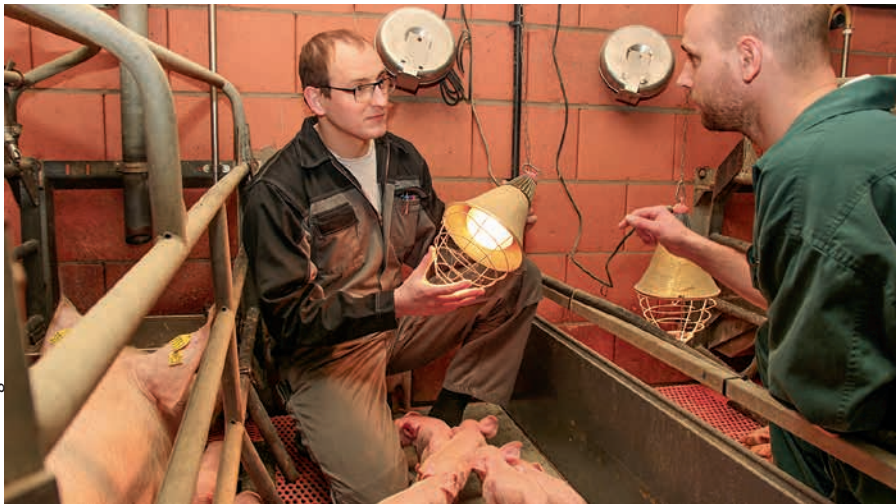
Durch den Austausch der 150 W-Infrarotlampen durch 100 W-Infrarotsparlampen werden in der Anlage knapp 3 500 € pro Jahr an Stromkosten eingespart.
